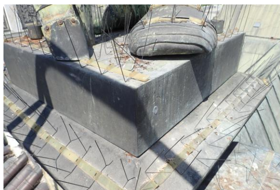
Zatmelený otvor po dokončení průzkumu.
