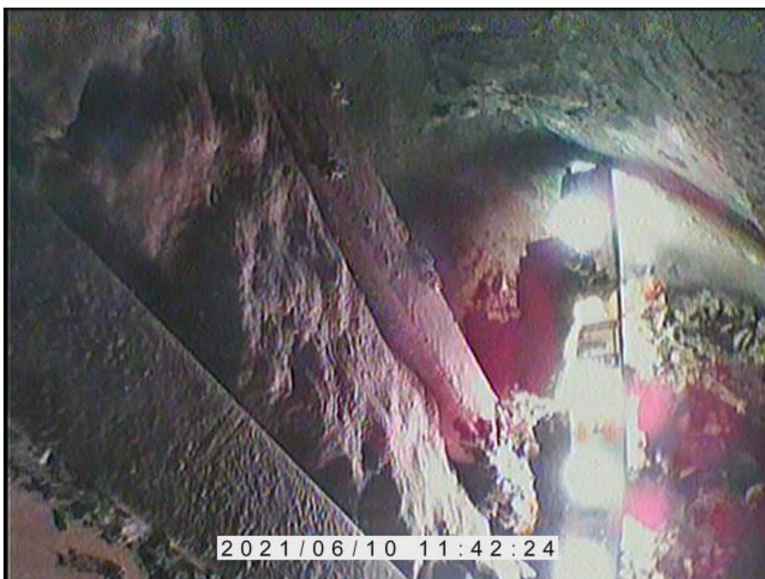
Uprostřed zkorodovaný původní nosník a ze stran jsou nové příložky.
