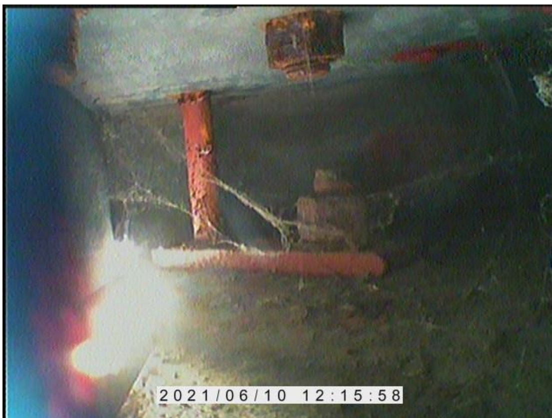
Pohled do bronzového soklu na jeden ze dvou hlavních kotevních šroubů.
