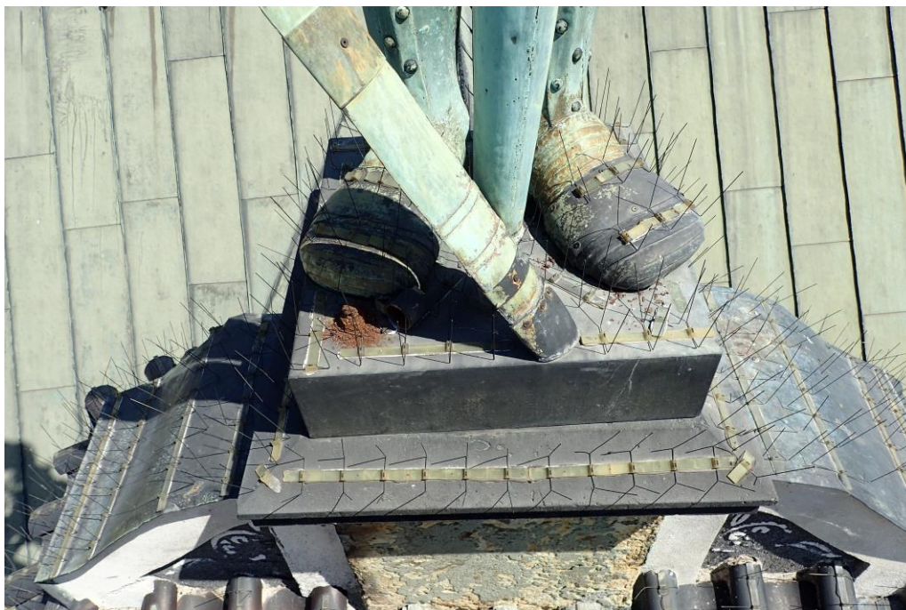
Současný sokl je bronzový odlitek o síle stěny cca 10 mm, bez vnitřní konstrukce.
