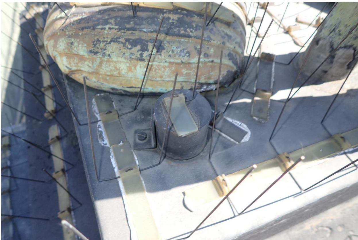
Oba kotevní šrouby jsou zakryty přišroubovanými krytkami. Přední kotevní šroub.
