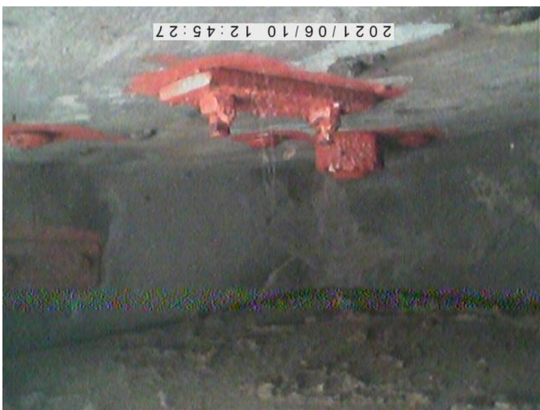
Pohled do protilehlého rohu soklu dokazuje, že kotevní šrouby jsou pouze dva.
